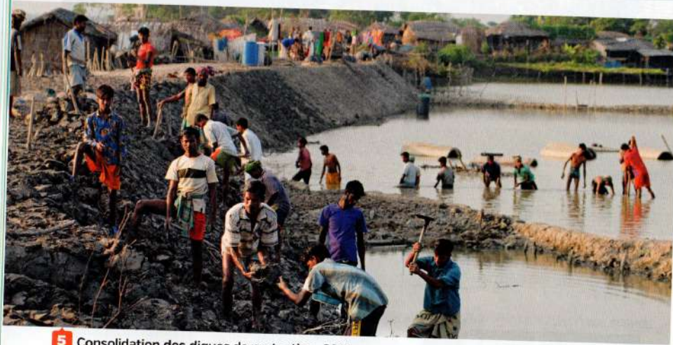
5 Consolidation des digues de protection, 2015 Les digues de terre sont consolidées de manière artisanale par les villageois du village de Kalabogji, au sud du Bangladesh.
